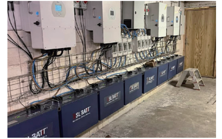
8* B-LFP48-170E 36kWh
