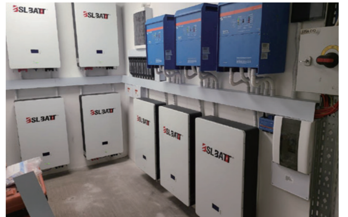
7* B-LFP48-200PW 70kWh
