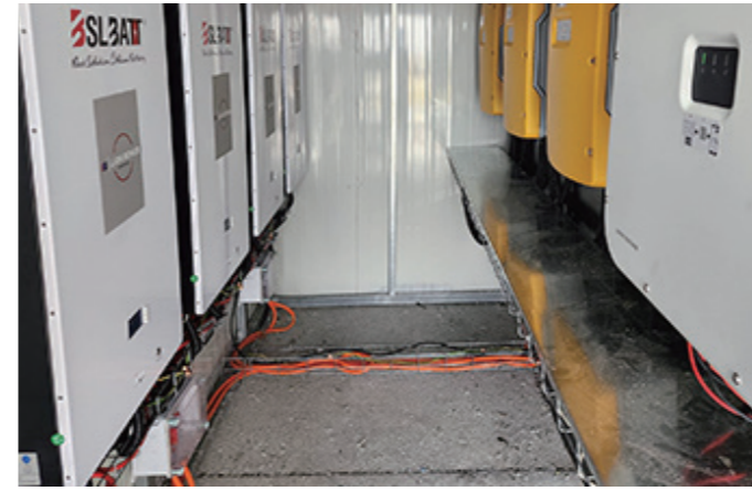
4* B-LFP48-200PW 40kWh
