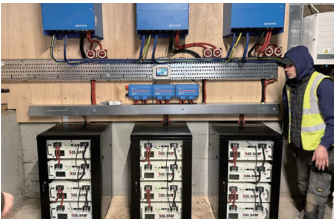
12* B-LFP48-100E 60kWh
