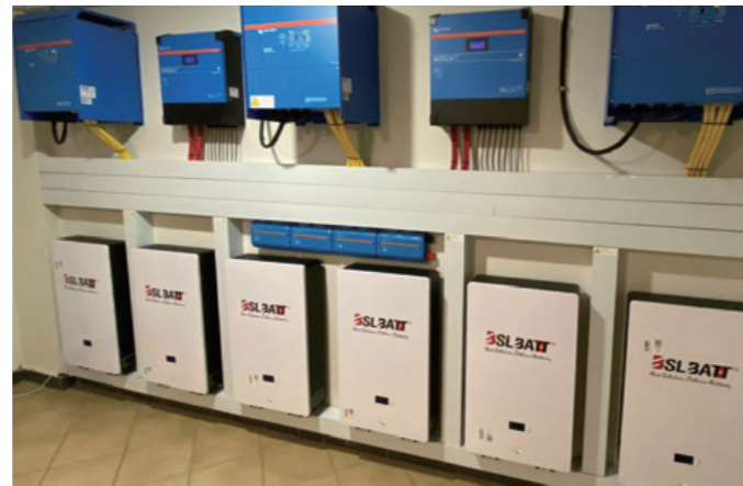
6* B-LFP48-200PW 60kWh
