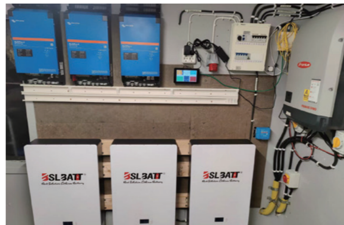
3* B-LFP48-200PW 30kWh
