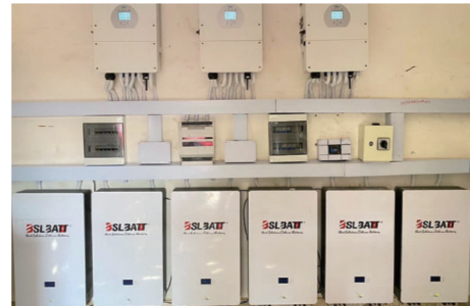
6* B-LFP48-200PW 60kWh
